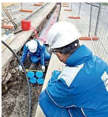
Lavori per interrare i cavi
