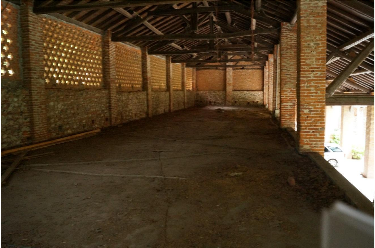
Corte Est, fienile sopra alle scuderie.
