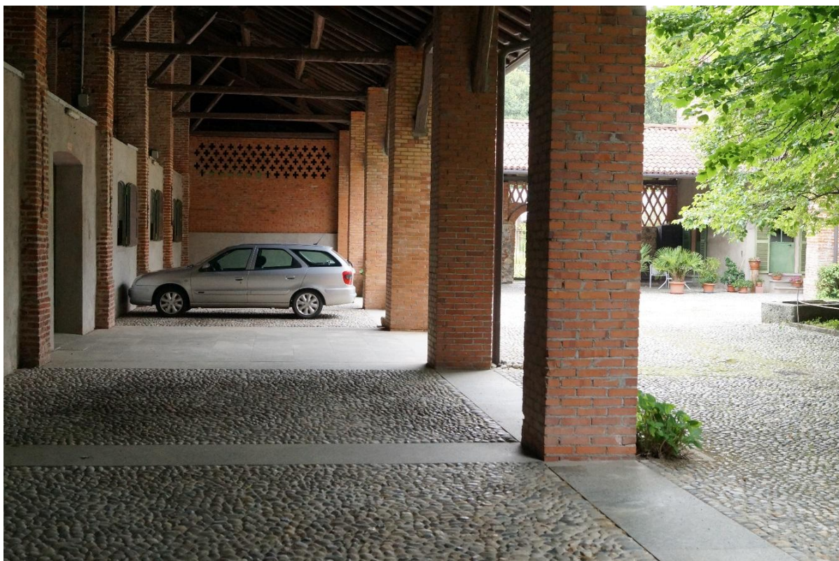
Corte Est, portico d'ingresso da adibirsi a deposito. Sulla sinistra, al piano terra area delle scuderie, al primo piano fienile.
