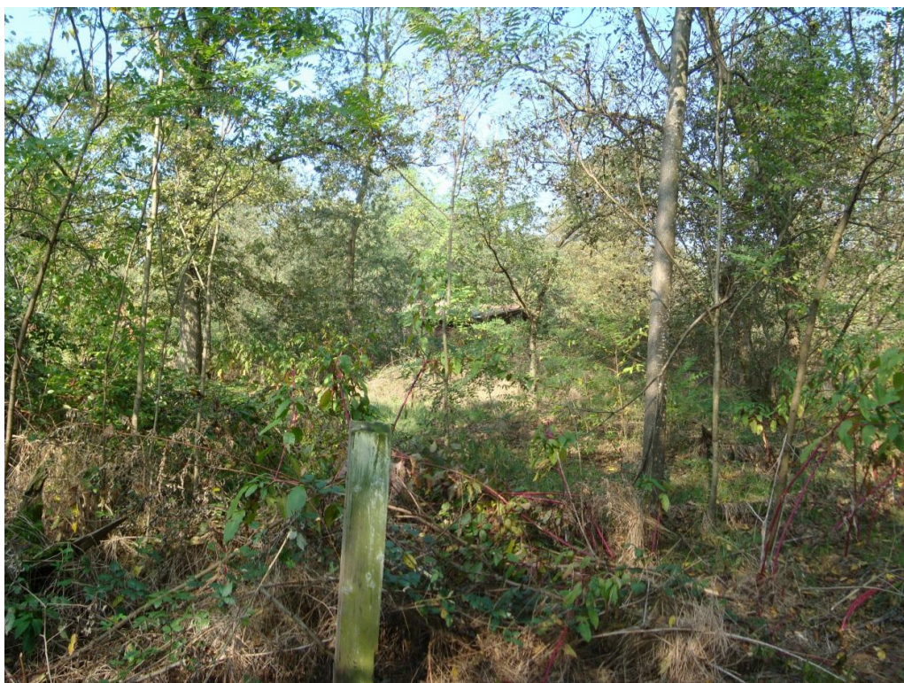
Recinzioni paddock posti a Sud: è visibile anche una struttura per il ricovero cavalli. Le strutture sono in abbandono e non sono più utilizzabili.
