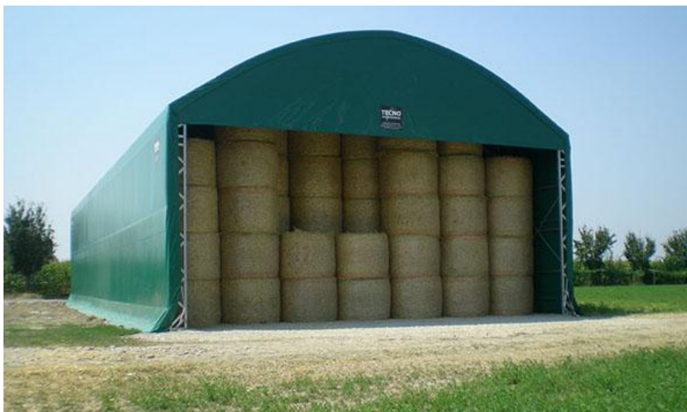
Fig. 24 - Esempio di tensostruttura per lo stoccaggio del foraggio.
