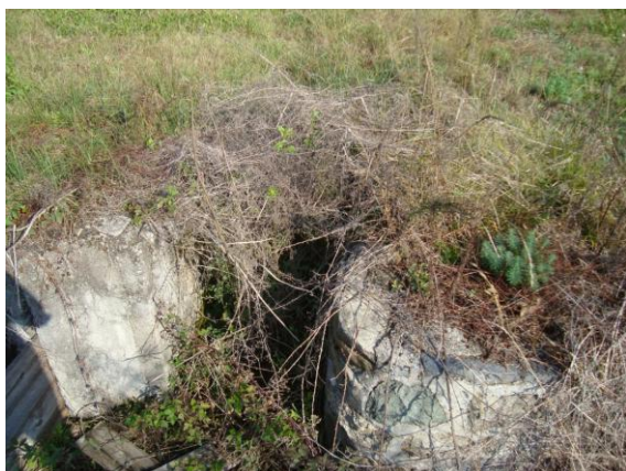
Fig. 5 - Esempio di manufatto del sistema di chiusura da ristrutturare.
